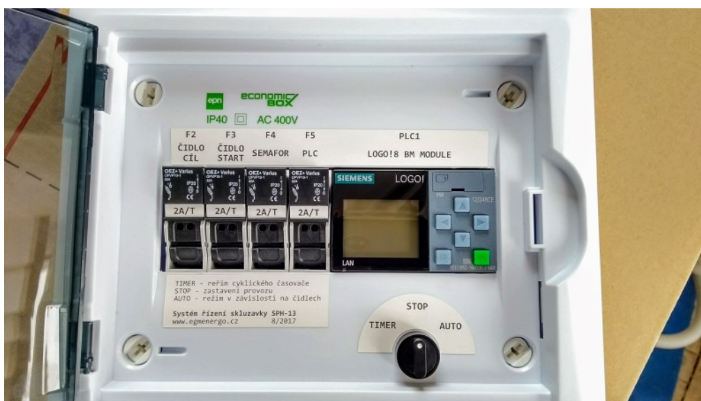
Obr. 9: Typické provedení řídicí skříň – provedení bez toboganu, instalace ve strojovně
