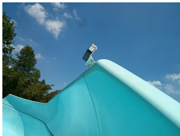
Obr. 2: Montáž difusního čidla na vyvýšenou postranici dráhy (před instalací ochranného krytu proti úrazu; lze jen tam, kde sehrazí úraz ruky, přidržuje-li se návštěvník hrany)
